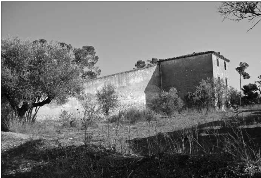
Fig. 10. Edifici dels masovers; a l'esquerra, veiem la paret inclinada que s'aprofita d'un corral i que dona la llargada del trinquet (2011)
