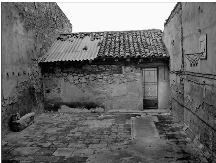
Fig. 3. Interior del trinquet de ca Jordà. Cal destacar el paviment de pedres grans, planes, ben treballades a primer terme —zona de sac—, i a continuació enrajolat. La construcció que hi ha al mig de la pista és, evidentment, posterior (2003)
