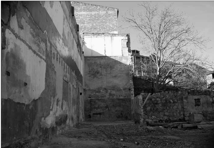
Fig. 6. Imatge central de la paret del frontó. Tant el terra com les parets laterals i el frontis estaven cimentats (2006)
