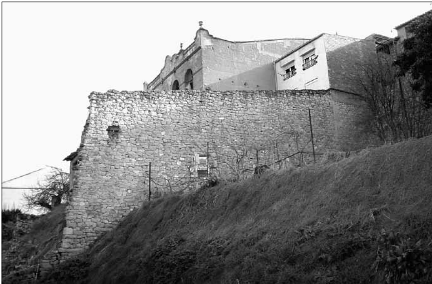
Fig. 2. Paret exterior del trinet de ca Jordà. Fixem-nos amb la considerable llargada i alçària (2003)
